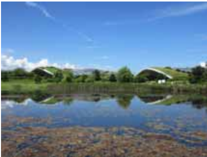
事例-4： アイランドシティ中央公園「ぐりんぐりん」。公園拠点施設を「花と緑の丘」を基本コンセプトに屋上と地上を連続させた緑地を創出し周辺景観とも調和（福岡県福岡市）
