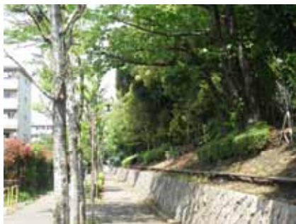
事例-2：三ツ目通り・首都高速9号深川線の環境施設帯 。築堤の住宅側の歩道にはアキニレの列植とツツジ類が植栽（東京都江東区辰巳）
