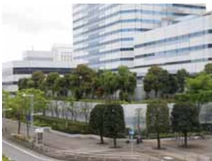
事例-1：幕張テクノガーデンの人工地盤の緑化 。階段状の植栽地にケヤキ・クスノキ・ヤマモモ等の高木を植栽（千葉県千葉市美浜区）
