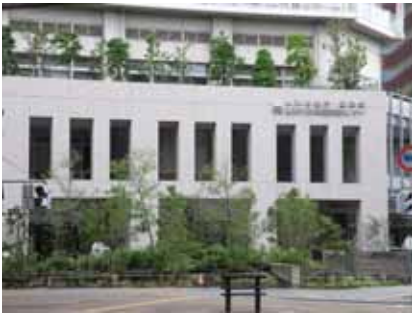
事例-1： 江東区豊洲出張所・区民間のベランダ緑化。建物外構も高木・中低木により植栽されている（東京都江東区）
