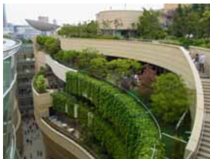
事例-2：なんばパークス・パークスガーデン 。階段状の商業施設の屋上を地上から8階に至る連続した公園緑地として整備し（大阪府大阪市浪速区）
