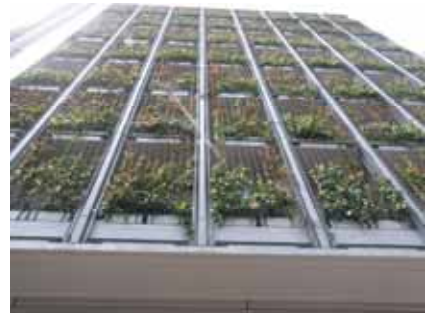
事例-6： 原宿警察署。壁面にプランタと登はん補助資材を設置しヘデラを導入して緑化（東京都渋谷区神宮前）
