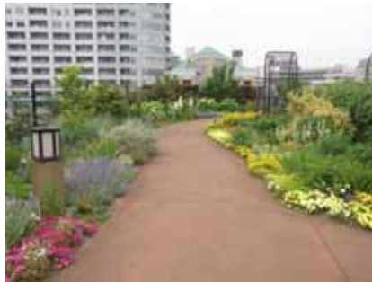
事例-2： 東京都下水道局ポンプ所東品川屋上庭園。ポンプ所の二階・三階の屋上を緑化し、バラ園・野草園・ピオトープなど潤いのある緑地空間を創出（東京都品川区東品川）
