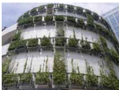
事例-8：横浜ベイウォーター 。複合商業施設のベランダにタブノキ等を植栽し、壁面はプランタや登はん補助資材を設置しヘデラで緑化している（神奈川県横浜市神奈川区）
