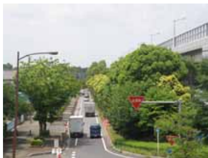
事例-9：東京外郭環状道路・国道298号 。高架道路の周辺に緩衝緑地帯としての緑豊かな樹林を形成している。大気浄化効果も期待される（埼玉県川口市安行）
