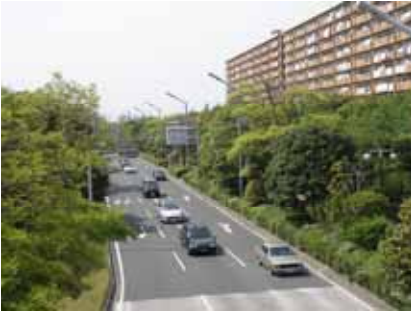
事例-1：事例国道 276 号の植栽帯 ．中央分離帯・歩道職妻帯の幅員を広くとって、高木・中低木の組合せによる複合植栽により緩衝緑地帯を形成している（千葉県浦安市美浜）
