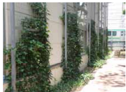
事例-9： 川崎駅東口駐輪場の壁面緑化。登はん補助資材を壁面に設置し、ヘデラの導入により緑化（神奈川県川崎市川崎区）
